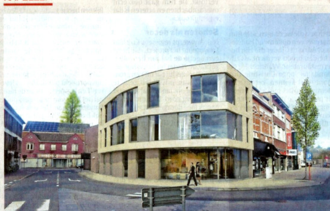
Dit moet het nieuwe uitzicht worden aan de ovonde in het centrum. Foto Mertens Architecten
